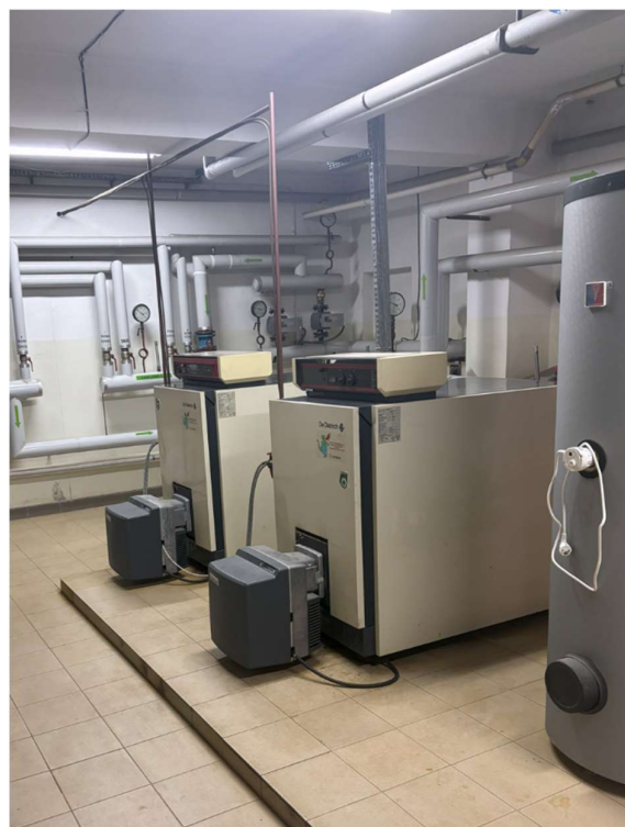
Zdjęcie 5 - Kotły olejowe oraz przepływowy podgrzewacz CWU
