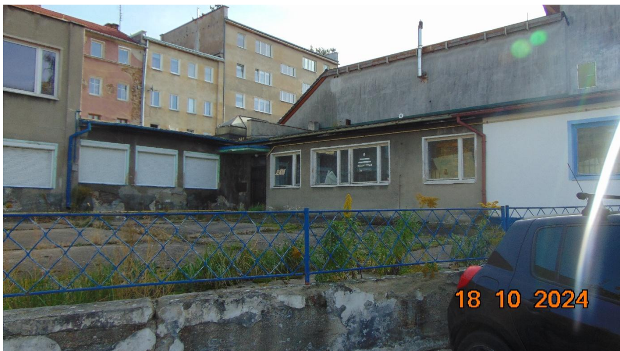
Widok budynku od frontu
