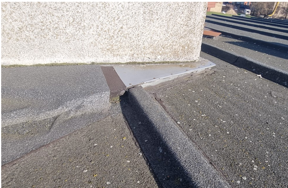
FOT. 3 – Wadliwie wykonane obróbki kominowe
