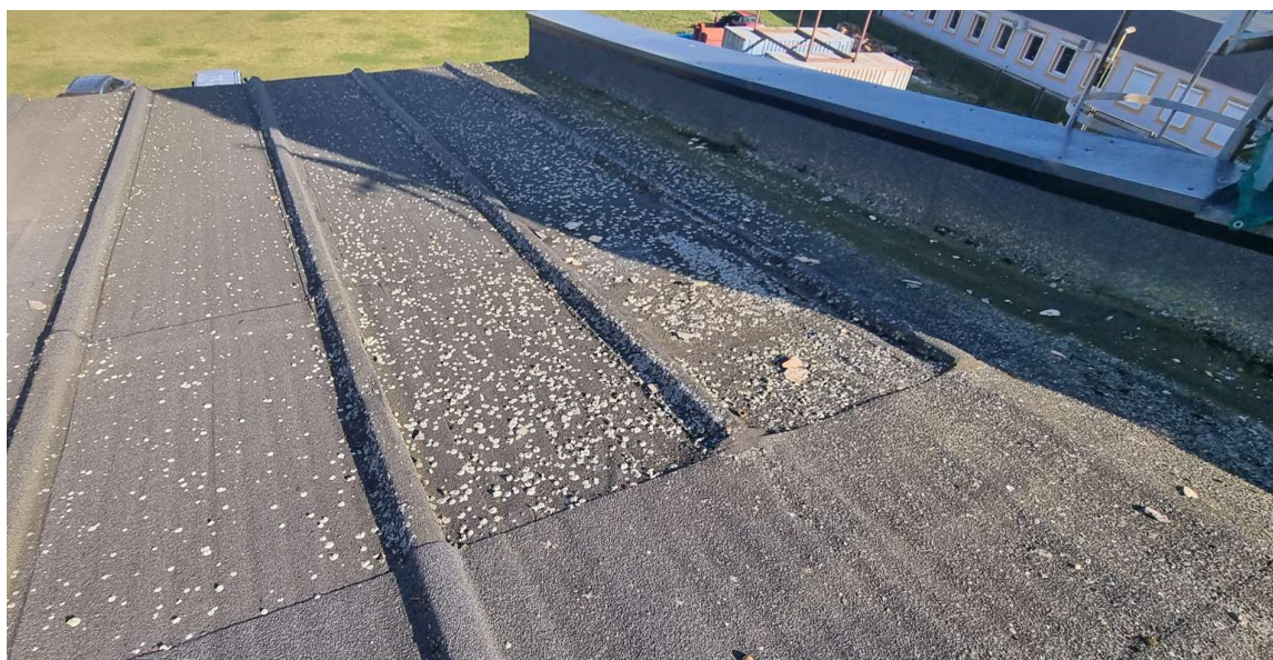
FOT. 2 – Widok połączenia dachu z porostami
