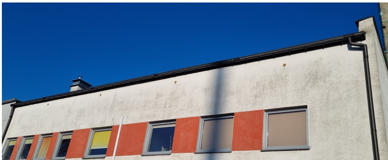
FOT. 10 – Widok elewacji z rozmieszczeniem otworów wentylacyjnych stropodach
