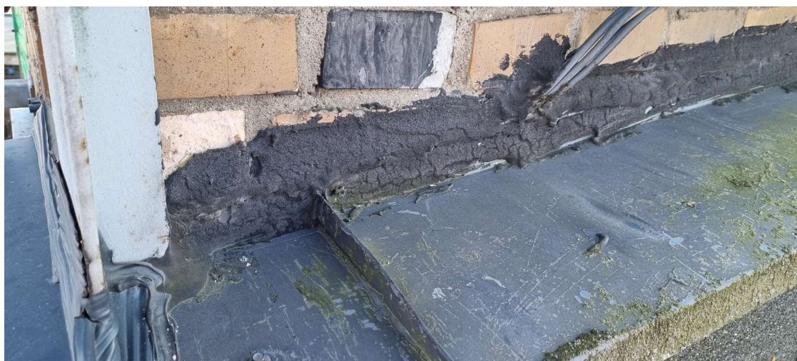
FOT. 7 – Widok połączenia attyki z przyległym kominem
