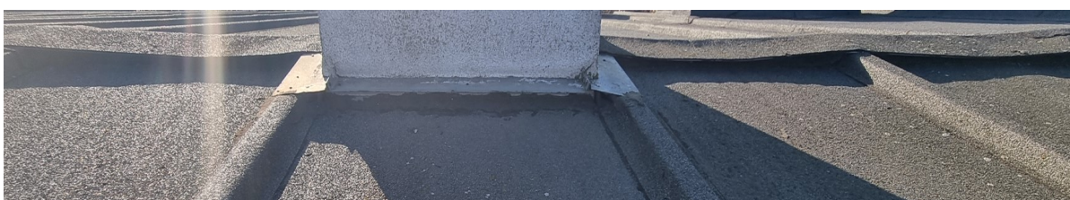
FOT. 5 – Wadliwie wykonane obróbki kominowe
