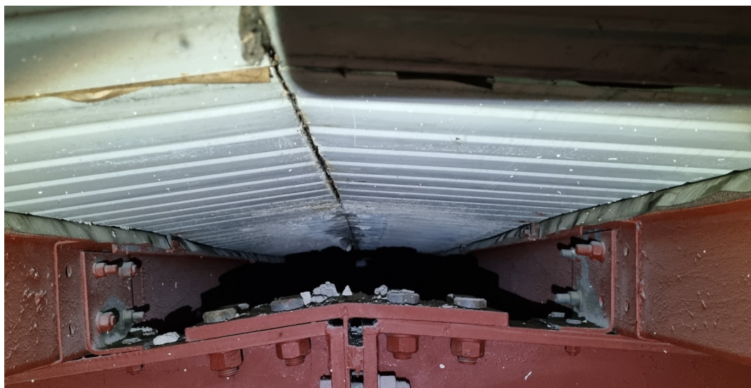
FOT. 11 – Ślady zawilgoceń na wewnętrznych powierzchniach stropodachu
