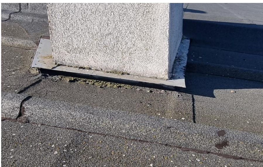
FOT. 4 – Wadliwie wykonane obróbki kominowe
