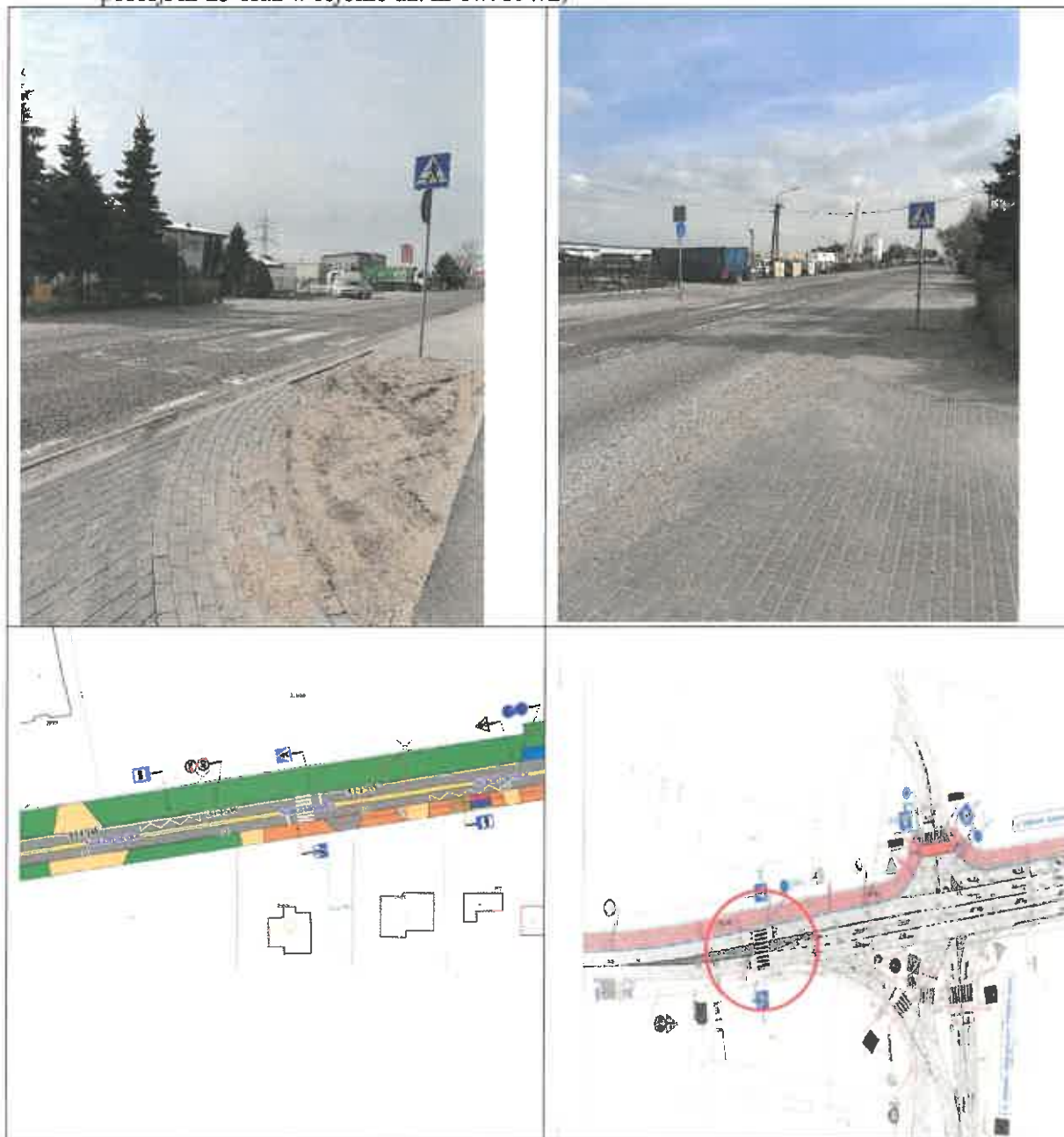
Gmina Michałowice – droga powiatowa nr 3115W – ul. Sokołowska w Sokołowie (w rejonie posesji nr 23 oraz w rejonie dz. nr ew. 397/2)
