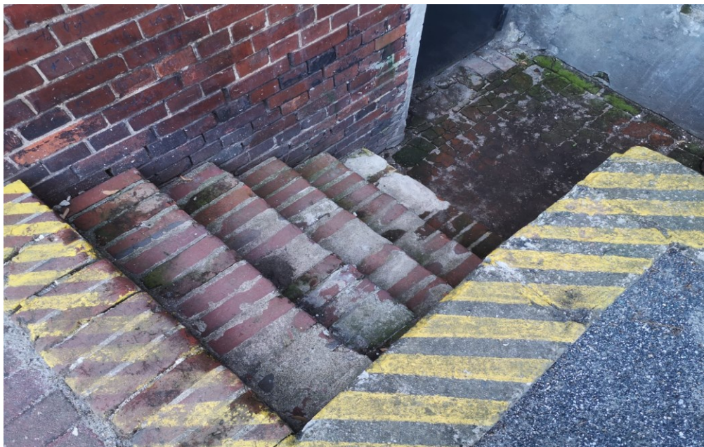
Zdjęcie nr 11 – schody zewnętrzne do piwnicy, widoczne wypłukane fugi, pojedyncze ubytki i uszkodzenia
