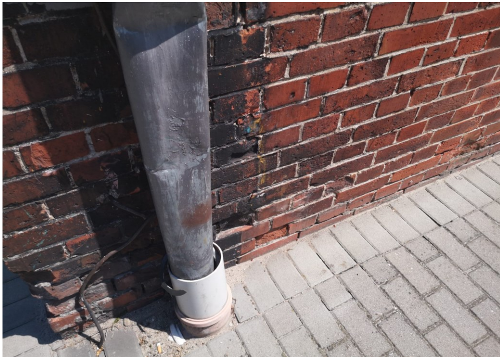
Zdjęcie nr 9 – uszkodzona rynnna w elewacji południowo - zachodniej
