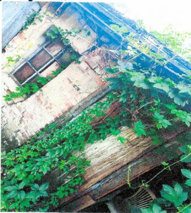
Widok budynku nr.1
