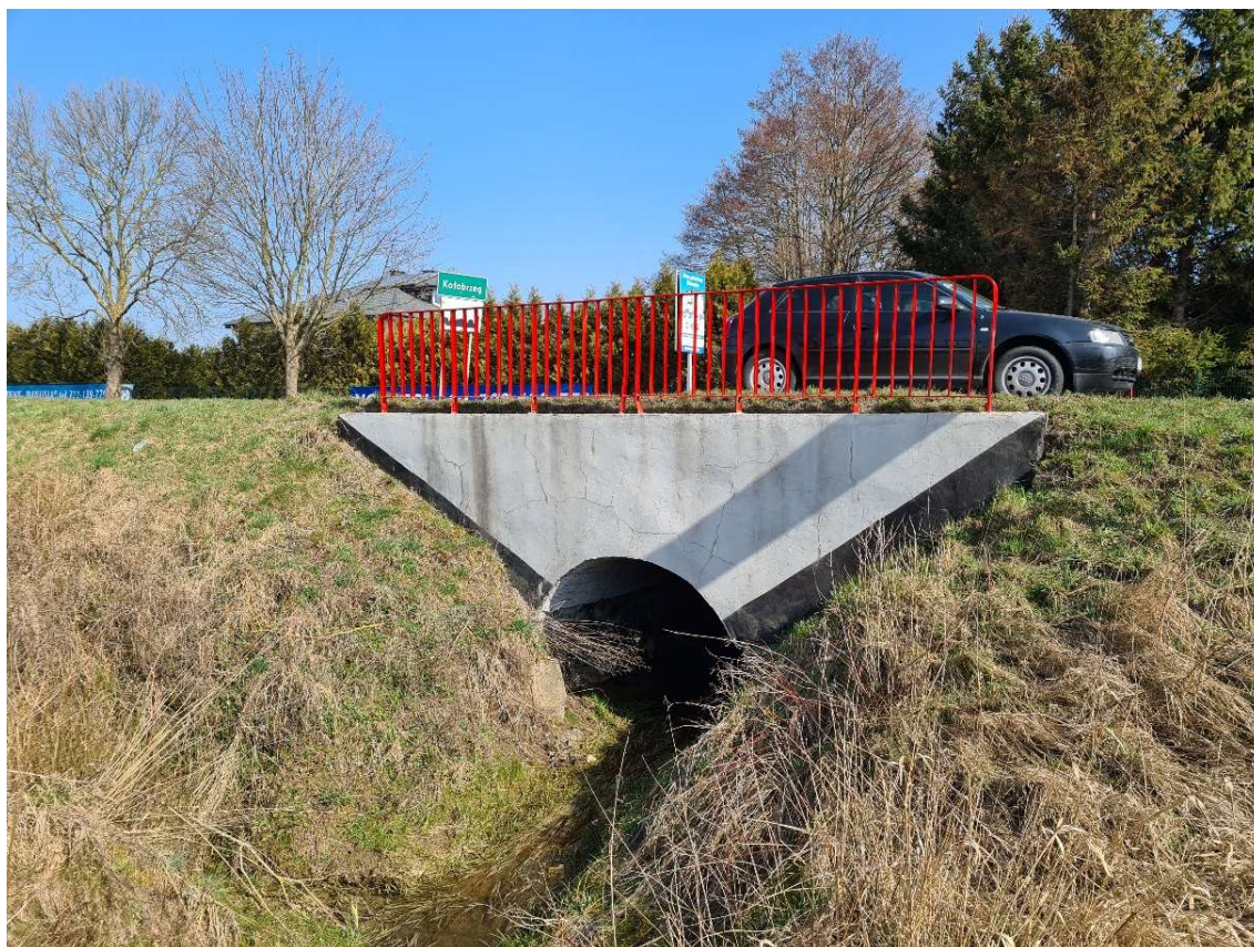
Fot. 3. Widok na głowicę wlotową przepustu.
