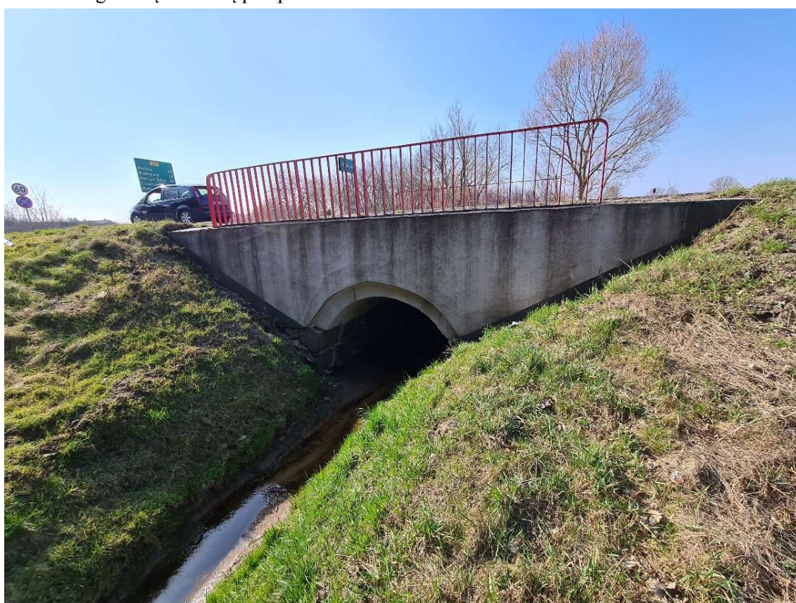
Fot. 4. Widok na głowicę wylotową przepustu.
