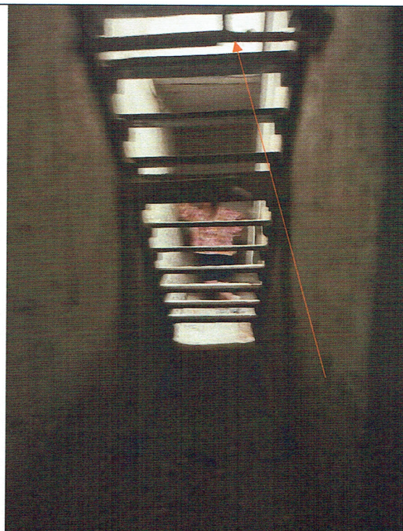
Zdjęcie nr 14- pomieszczenie 00.12b pomieszczenie piwniczne. Miedzy 10, a 11 stopniem przebiega pozioma rura wody. W wskazanym miejscu brakuje podłogi na gruncie. Zamontowana jest na wysokości 2,1 od gruntu.
