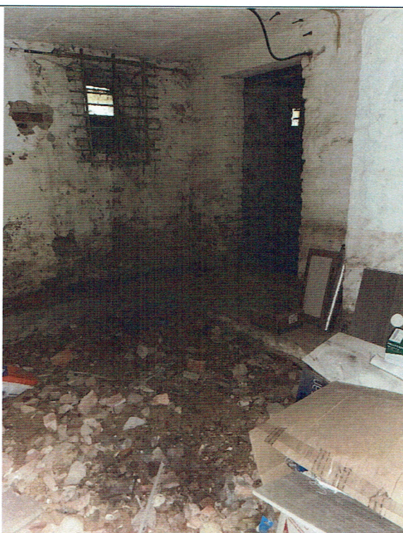
Zdjęcie nr 12 – widok pomieszczenia należącego do lokalu Gdańskich Nieruchomości. Wg wywiadu z osobą wynajmującą ogłoszenie instalacja elektryczna nie działa, brak podłogi na gruncie.
