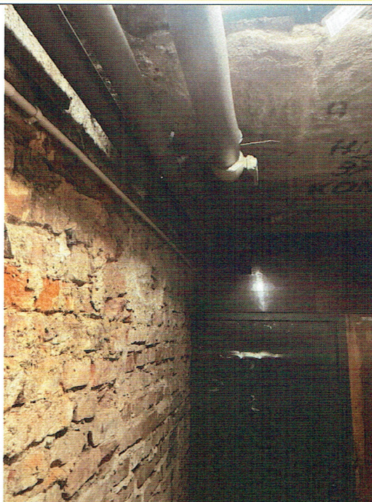
Zdjęcie nr 7 – instalacja wody, centralnego ogrzewania oraz przewód elektryczny zasilający oświetlenie ogólne w pomieszczeniu 00.08. Widok skierowany jest naprzeciwległą ścianę ze zdjęcia nr 7.
