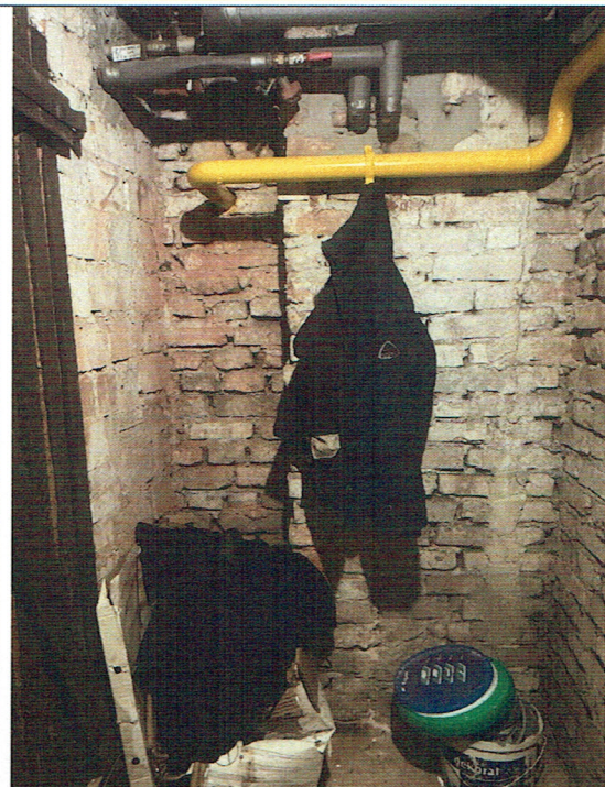
Zdjęcie nr 7 – instalacja wody, centralnego ogrzewania oraz wody w pomieszczeniu 00.08 przy osi „6”ściana pomieszczenia z pomieszczeniem kolektora centralnego ogrzewania
