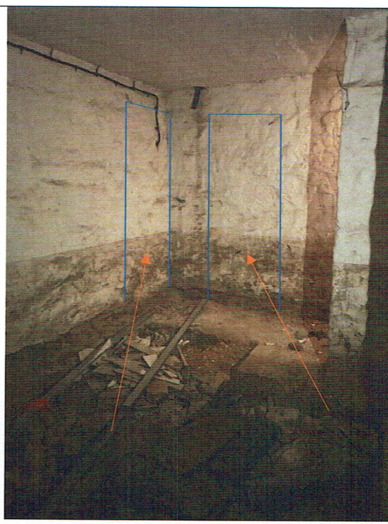
Zdjęcie nr 15 – pomieszczenie 00.12b, skrzyżowanie osi „5” z osią „b”, jest to miejsce wykonania planowanego przejścia z korytarza 00.01 do pomieszczeń piwnicznych 00.09,00.10 i 00.11. Instalacja elektryczna widoczna na zdjęciu zostanie przebudowana
