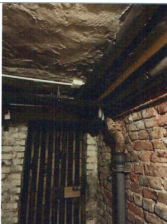
Zdjęcie nr 4 – widoczna instalacja centralnego ogrzewania wchodząca do pomieszczenia 00.14
