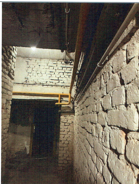
Zdjęcie nr 3- instalacja gazu, elektryczna i wody prowadzona po ścianie w przejściu pod podciągami w osi „b”
