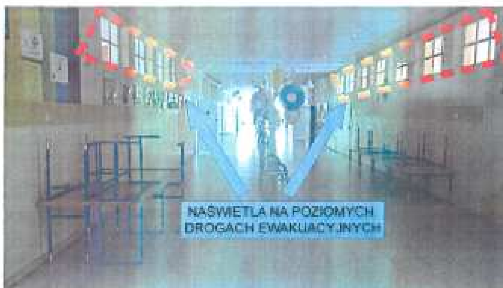
Rysunek 3: Naświetla na poziomych drogach ewakuacyjnych nieposiadające wymaganej klasy odporności ogniowej EI 15
