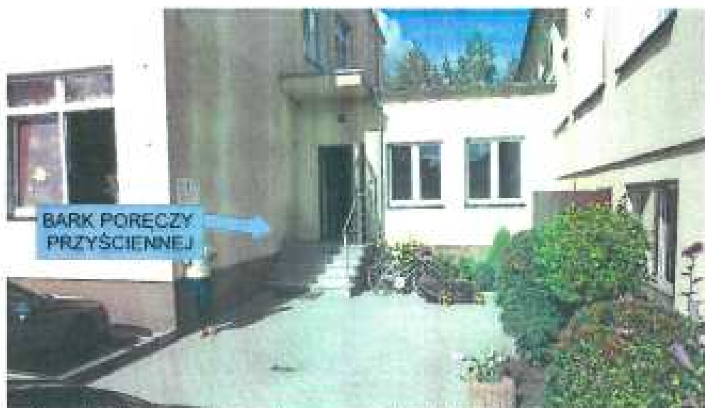
Rysunek 4: Istniejące wyjście ewakuacyjne z przedszkola (przez strefę ZL III); brak poręczy przyściennej - zostanie wykonana w I etapie inwestycji; szerokość spocznika 125 cm < 150 cm wymagane
