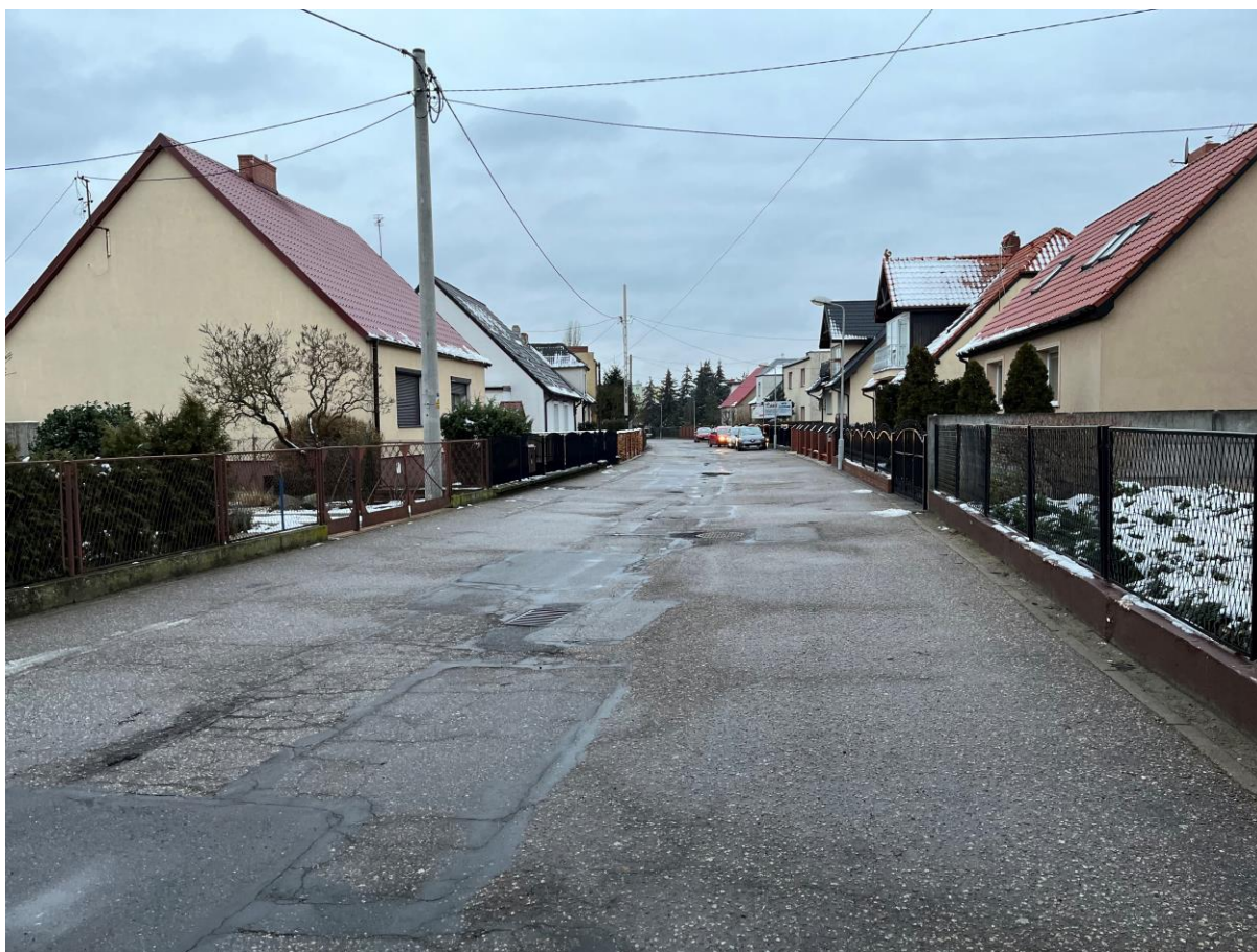
Zdj nr 7 – liczne uszkodzenia nawierzchni, ul Sienkiewicza (km 0+168-0+331)
