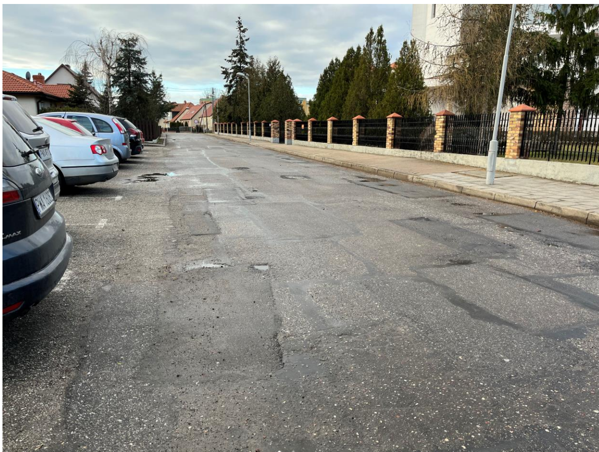
Zdj. nr 5 – widoczne łaty i nierówności
