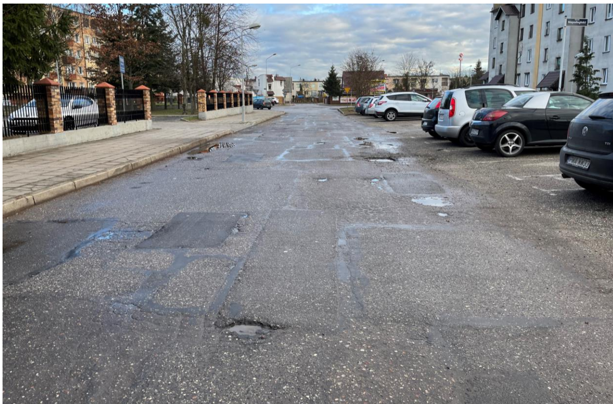
Zdj. nr 4 – widoczne nierówności, wykruszenia i łaty
