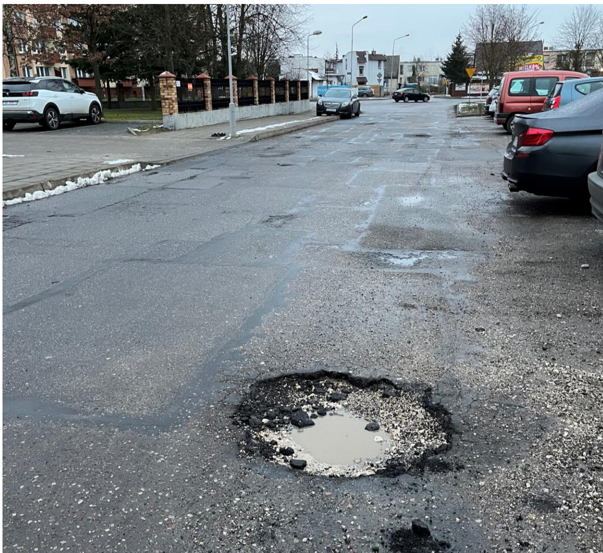
Zdj. nr 3 – ubytki w nawierzchni, łaty
