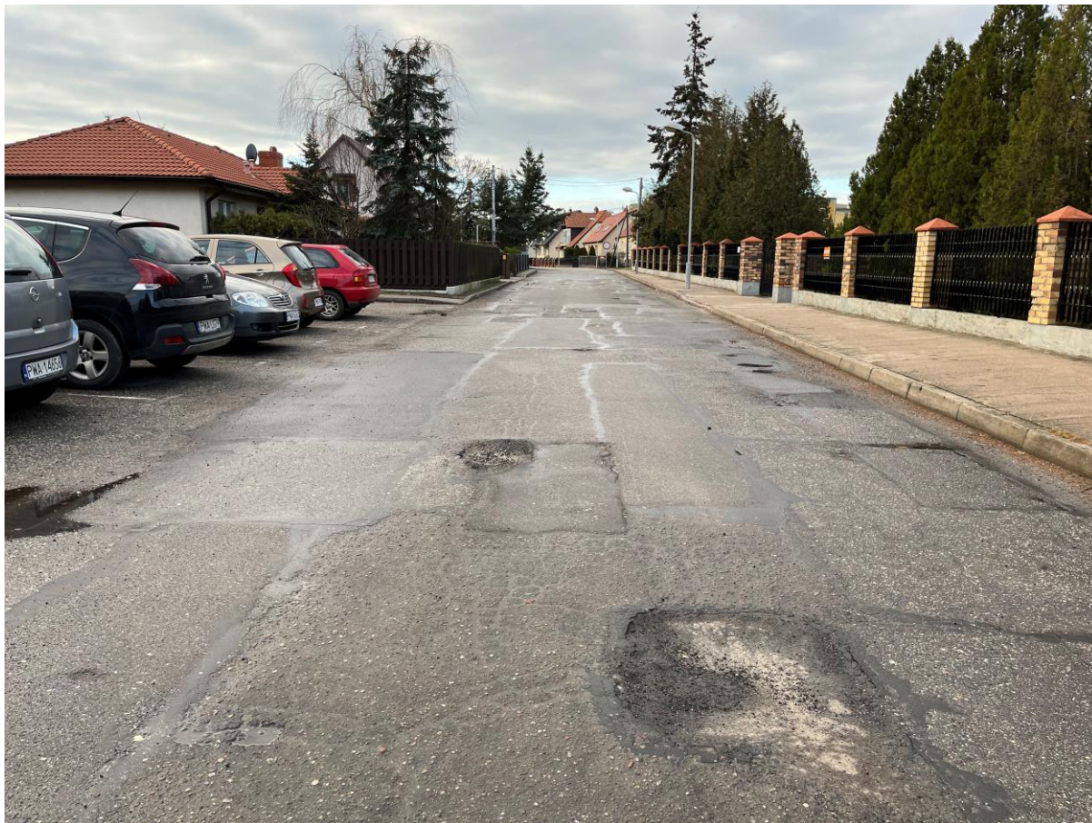
Zdj. nr 1 – widoczne liczne łaty, wykruszenia i spękania siatkowe
