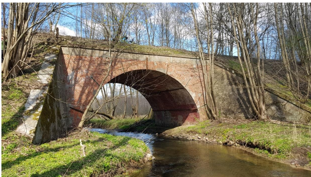
Most nad rz. Dębnicą (ceglany).
